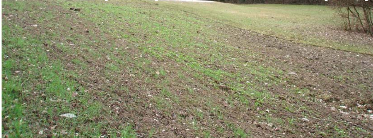
Ansicht des Dammstandortes
