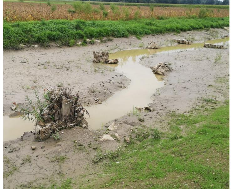
Durch die Errichtung eines Sandfangs am Beginn der Renaturierungsstrecke und die Förderung abwechslungsreicher Sohlverhältnisse können unerwünschte Sedimentablagerungen mit hohen Feinanteilen hintangehalten werden. Für die Wartung und Räumung des Sandfangs wird in Fließrichtung rechts ein Begleitweg angelegt.
